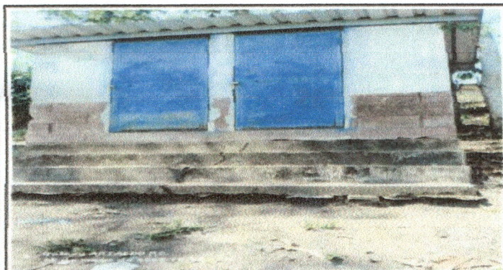
Foto 3: MANTENIMIENTO DE PUERTAS LIJADO, SEPILLADO Y APLICACIÓN DE PINTURA EN PUERTAS Y MURO EXTERIOR E INTERIOR
