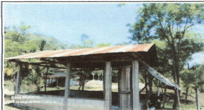
Foto 2: CUBIERTA DE LAMINA DE COCINA SUSTITUCIÓN DE LAMINA POR LAMINA TROQUELADA Y SUSTITUCIÓN DE SOPORTE DE MADERA POR COSTANERAS GALVANIZADAS.
